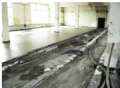
Рис. 1. Производство пенобетона в построечных условиях
