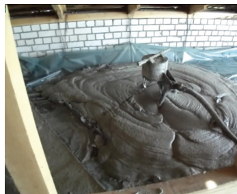
Рис. 1. Производство пенобетона в построечных условиях
