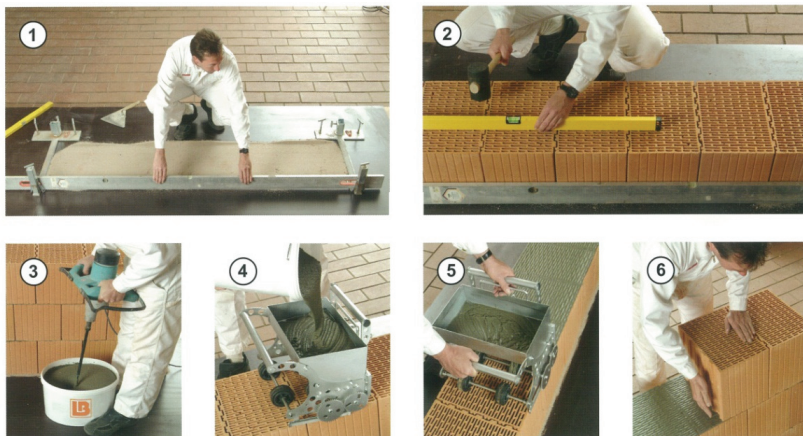
Рис. 2. Нанесение раствора на горизонтальную постель кладки
