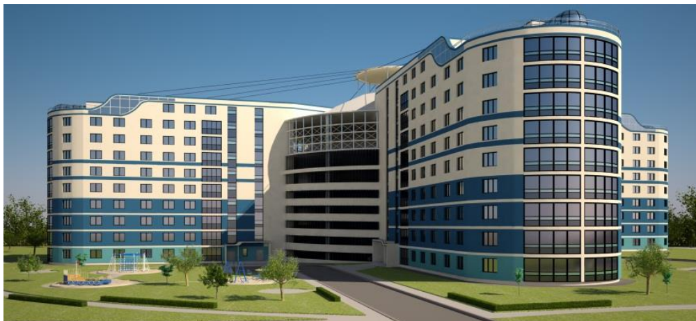
Рис. 3.5. Внешний вид энергоактивного комплекса жилых зданий
